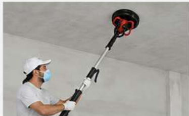
Aplicación de yeso en techos
