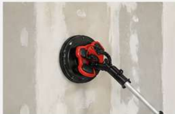
Acabados y alisado de masillas
