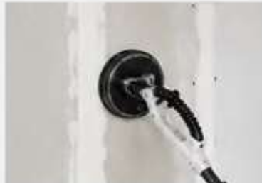
Acabados en juntas y masillados
