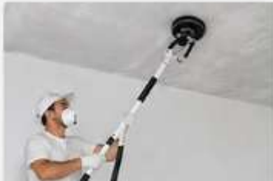
Lijado de techos
