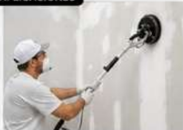
Lijado de paredes
