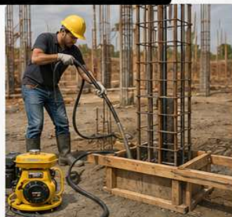
Vibrado de columnas
