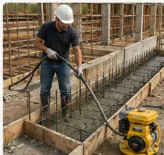
Vibrado de vigas y fundaciones
