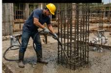
Vibrado de columnas
