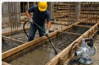
Vibrado de vigas y fundaciones
