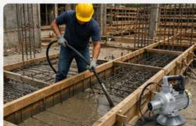
Vibrado de vigas y fundaciones
