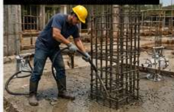
Vibrado de columnas
